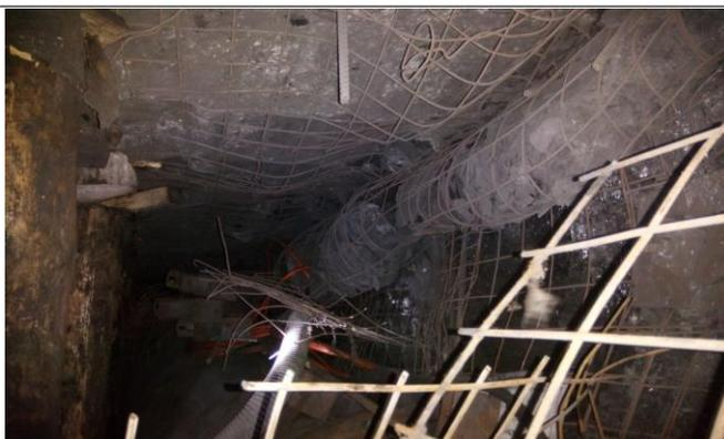
Рис. 1. Виды разрушения угля, пород и элементов крепи в подготовительной выработке
