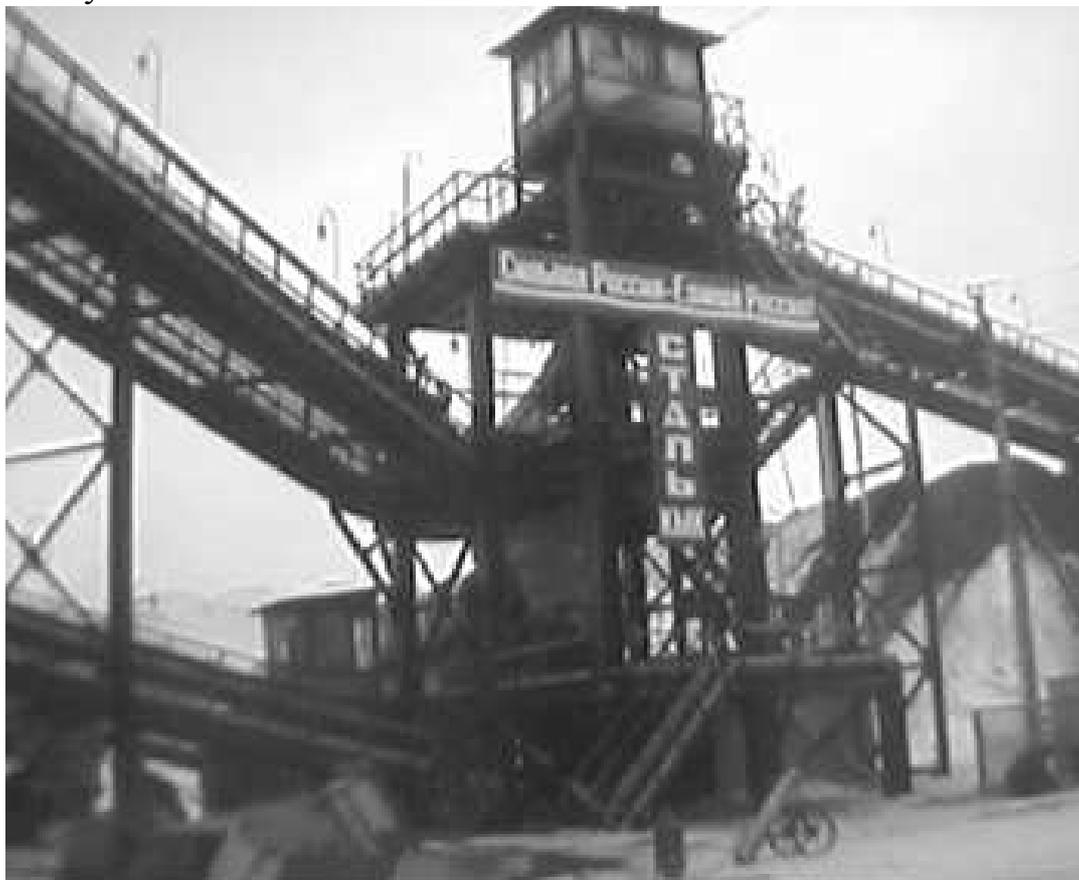
Рисунок 2 – Общий вид установки по переработке и магнитной сепарации отвального мартеновского шлака
