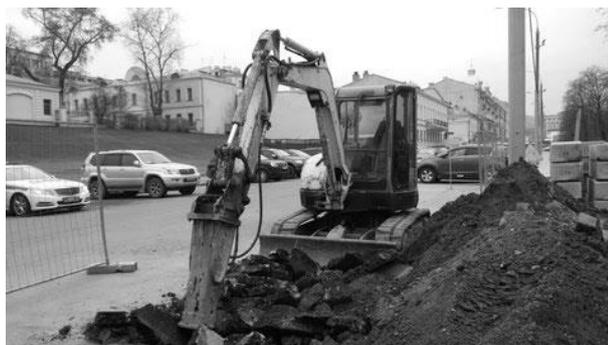
Рисунок 6 – Общий вид гидромолота, используемый для разрушения асфальтового и бетонного покрытий
