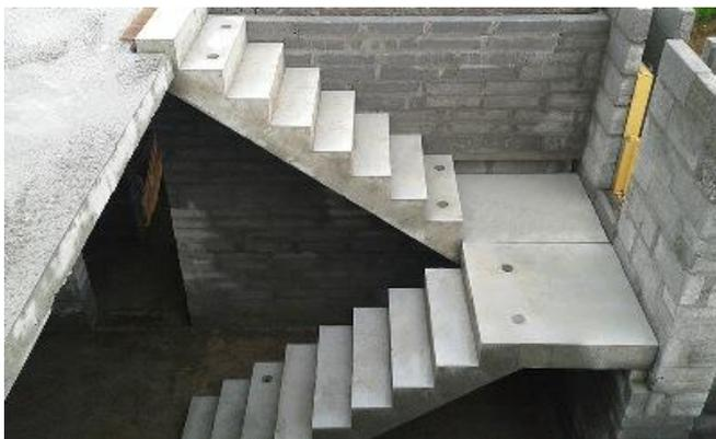
Многоэтажные здания чаще всего оборудуются полносборными лестничными маршами и площадками заводского изготовления из железобетона – рисунок 9.
