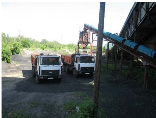
Рисунок 8 - Отгрузка кокса через расходные бункера, справа галерея загрузки угля
