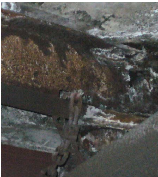
Рисунок 1 - Вырез в стенке двутавра для подвеса оборудования
