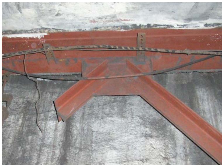
Рисунок 2 - Удаление ветви крестовой связи для размещения оборудования
